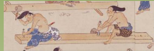
板を割裂している様子
