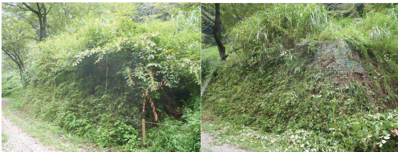
左：作業前、右：作業後
