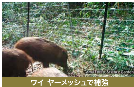
ワイヤーメッシュで補強 イノシシがかじる高さを考慮し 高さ 1200mm のメッシュ・目合 75mmx220mm
