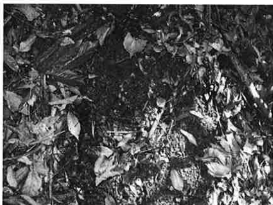
写真 3. 斜面の地表面の状況
