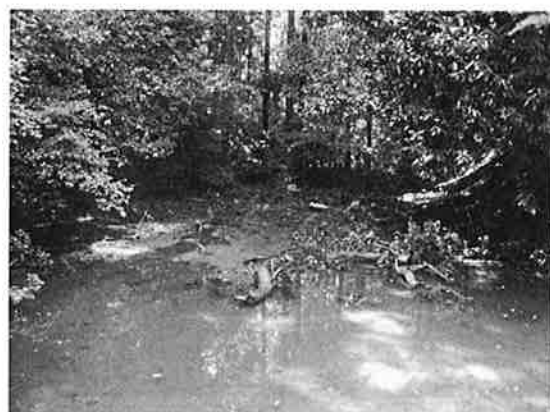
写真14. 展示館上流の池への崩土の流入状況。
