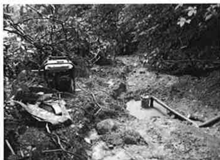
沢の水をポンプで汲み出しながらの作業
