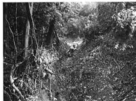
沢上流の崩落現場の調査に向かう 庶務課長と損保鑑定人
