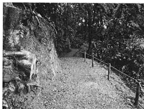
完成した新設歩道
