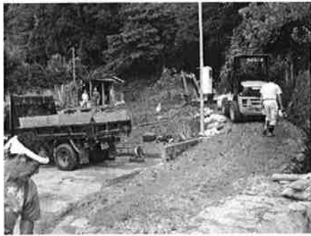
重機による倒木の搬出作業
