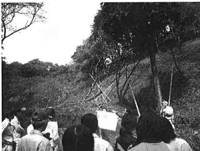
道が崩れた様子の見学
