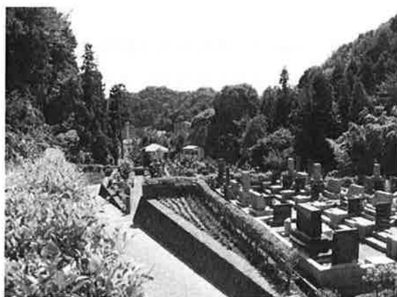
写真 5. 土石流危険箇所の土砂堆積状況 （船底地形）
