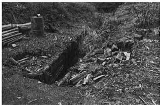
写真 9. 既設堰堤間の狭窄部
