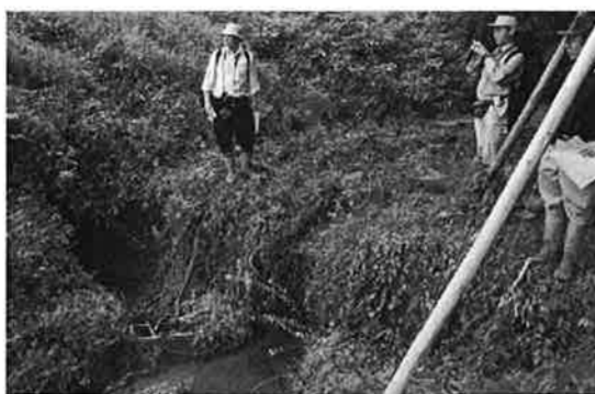
写真 10. 既設の蛇籠による小規模堰堤。 後方に流出土砂を堆積している。
