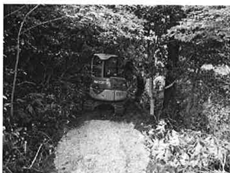
歩道新設工事の様子
