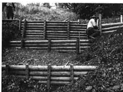
土留作業の様子
