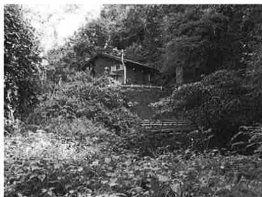
写真 12. トイレ下部の応急対策
