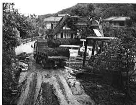
重機による土砂と倒木の搬出作業
