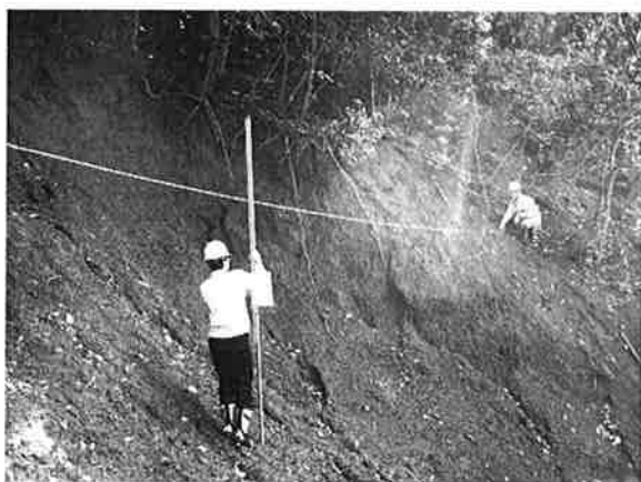
写真 1. 崩壊地源頭部の状況
