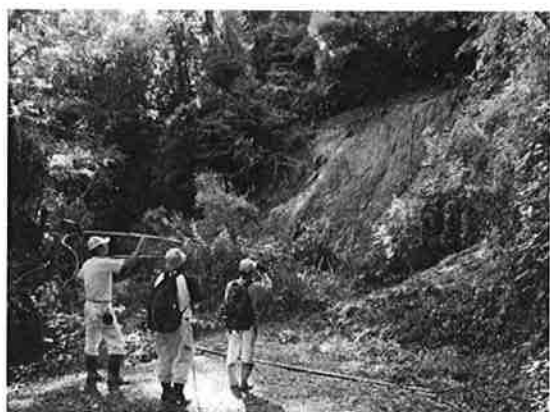
写真 6. 土石流危険渓流の源頭部崩壊
