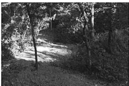
写真 11. 蛇籠堰堤後方の堆砂状況。 十分土砂を捕らえている。
