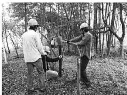
写真-1 竹林管理区域杭打ち込み作業
