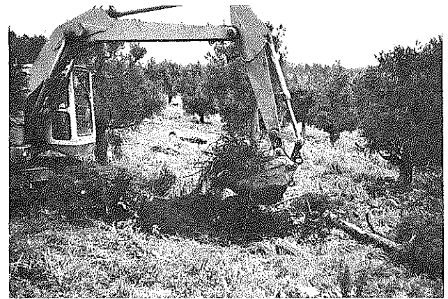
バックホーによる伐根の掘取り作業
