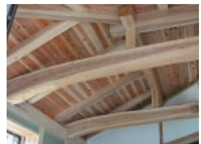
写真－６ 曲がり材の活用
