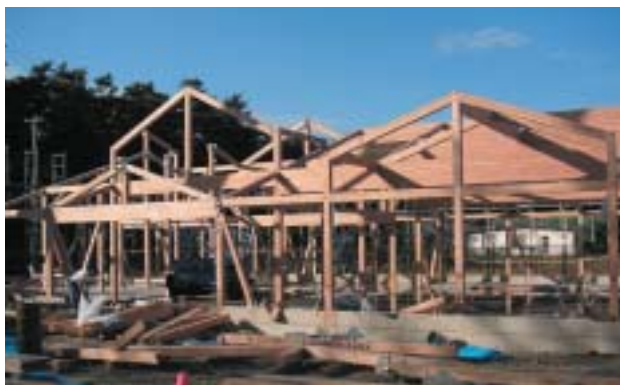
カラマツ大断面集成材工法を採用した庁舎建設
