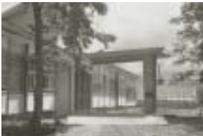
旧庁舎(1959年建設)
