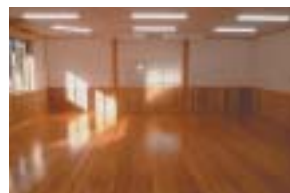
床板、腰板に間伐材を利用した会議室
