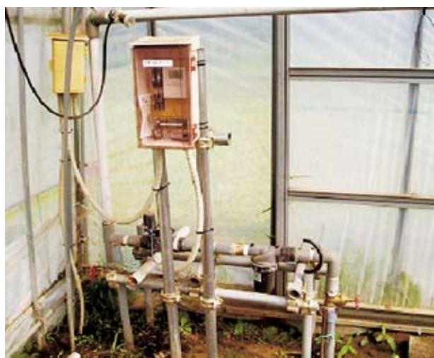
タイマープログラムによる自動灌水装置
