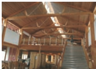
カラマツ集成材による建築物 遠野市立青笹小学校
