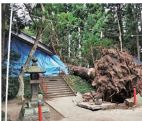
写真-1 根元から倒壊し本殿の一部を破損
